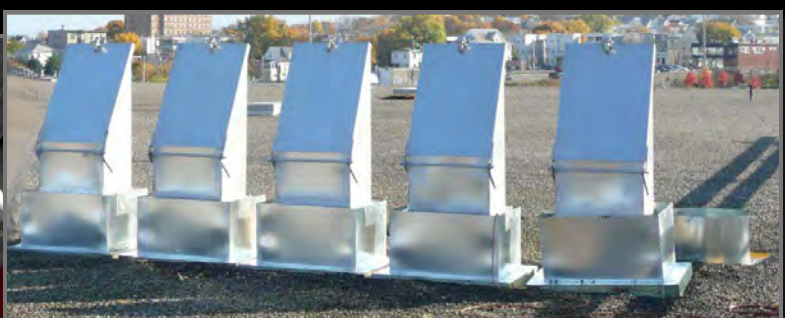
RPO6 - Left Explosion Vent
